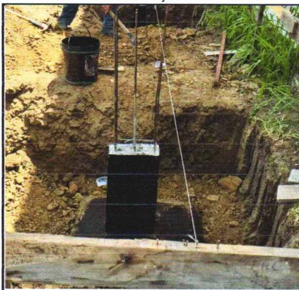
FOTO - 08 IMPERMEABILIZAÇÃO DE SUPERFÍCIE
