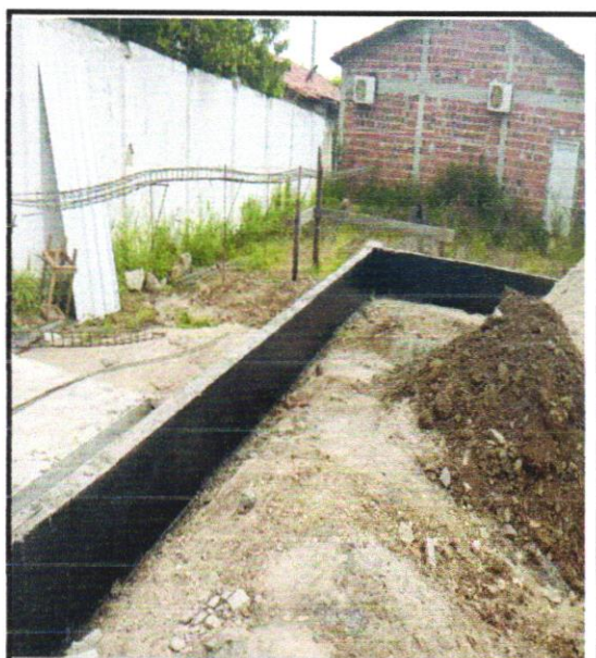
FOTO 11- IMPERMEABILIZAÇÃO DE SUPERFÍCIE
